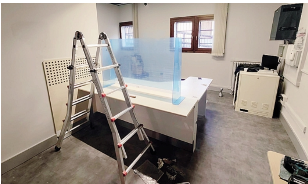
Lavori in corso all'ufficio postale di Colere
