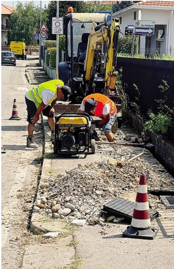
Bonate Sopra, i lavori di installazione dei nuovi impianti semaforici all'incrocio tra via San Rocco e via Nullo
